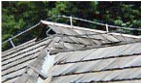
**Blitzschutzanlagen** müssen regelmäßig durch eine Fachfirma überprüft werden. Ein positives Prüfprotokoll muss vorliegen.
