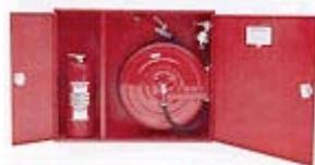
Die Einrichtungen der **erweiterten Löschhilfe** (Wandhydrant, nasse oder trockene Steigleitung) sind jährlich einer Funktionskontrolle und alle 4 Jahre einer Druckprüfung zu unterziehen.
