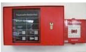
**Brandmeldeanlagen, Rauch- und Wärmeabzugesanlagen und stationäre Löschanlagen** sind jährlich von befugten Fachfirmen zu warten. Eine positive Abnahmeprüfung durch eine akkreditierte Prüfanstalt muss vorliegen.
